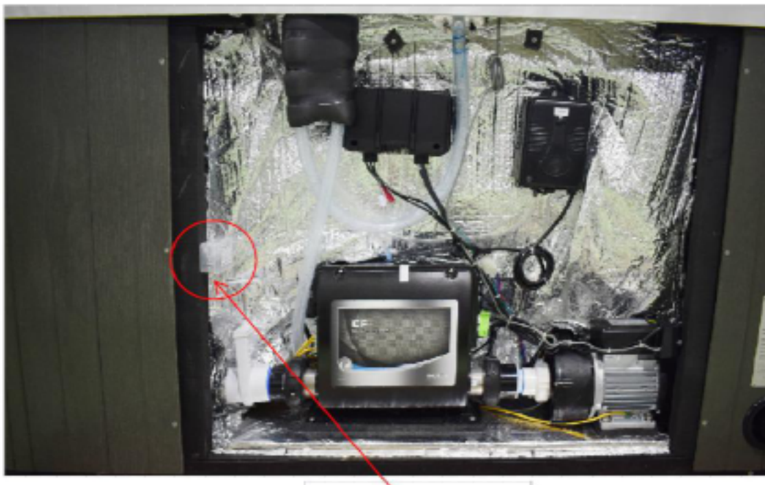
Расположение дополнительного предохранителя
