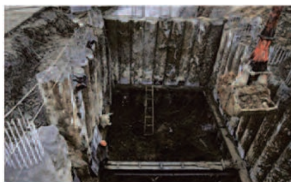
Устройства «стены в грунте» буросекущими сваями
