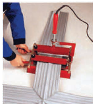
Сварка гидрошпонок между собой с помощью кондуктора
